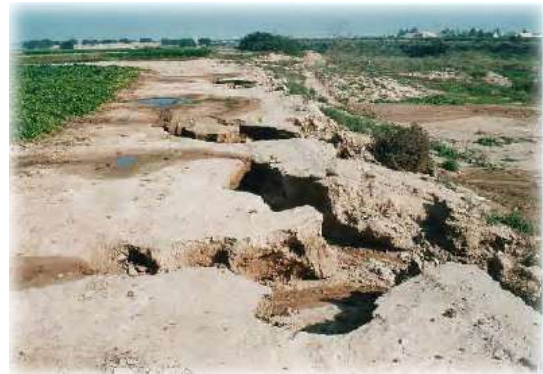
Διάβρωση από Χείμαρρο
